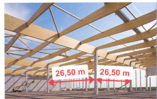
Insbesondere in den Torachsen hat sich das Primäraster von 25 Metern bewährt
